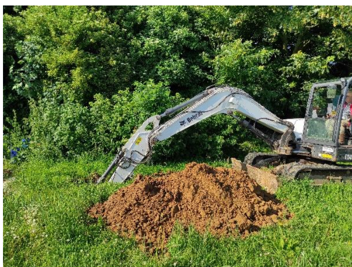
Cliché 1 : Creusement des fosses pour les essais Matsuo (crédit explor-e)
